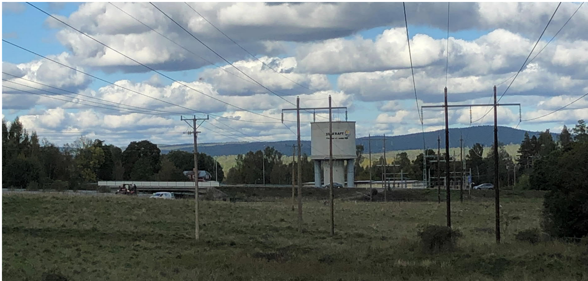
Figur 4. Befintlig LL1 i mitten, som planeras att byggas om till samma konstruktion som LL3 till höger
