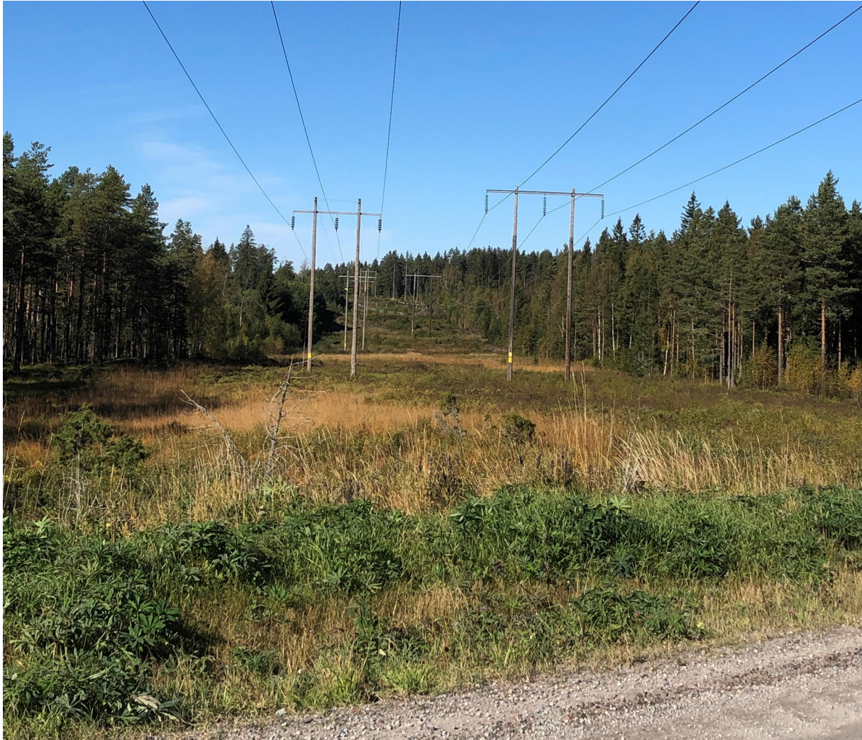
Figur 8. Kuperad terräng i skogsmark, LL1 till vänster i bilden. Ledningsstolparna ska placeras så dom harmoniserar bättre efter ombyggnaden.
