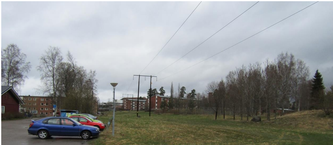
Figur 1. Befintlig 145 kV luftledning vid Grågåsvägen i Marnäs, där en ny skola planeras att byggas till höger om ledningsgatan i bilden.
