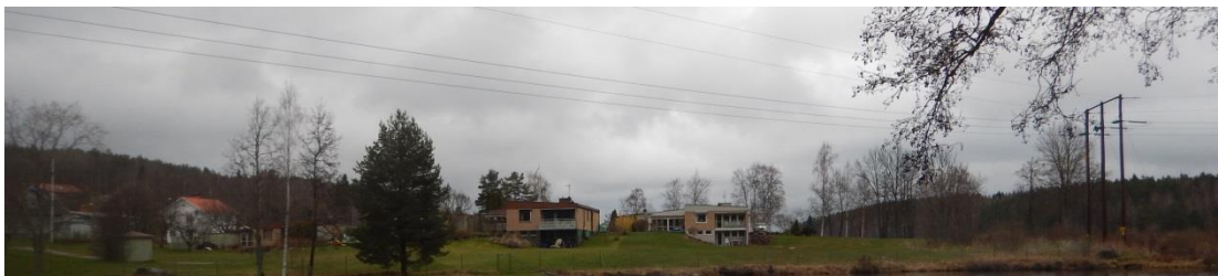
Figur 5. Den befintliga luftledningen vid Gårlången kommer att raseras, och därmed upphör dess påverkan på landskapsbilden.
