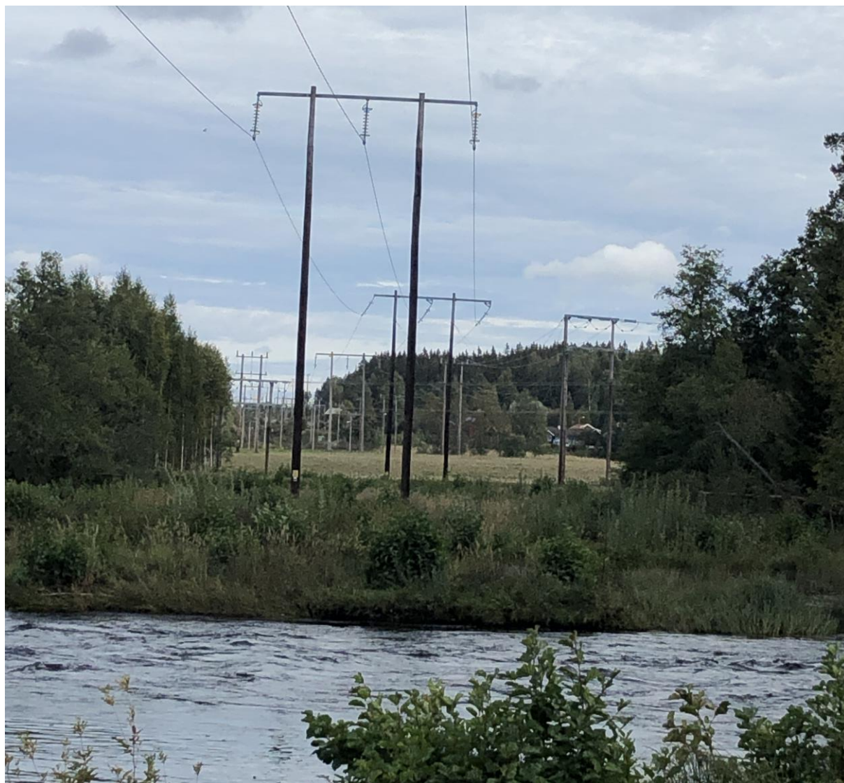
Figur 8. Befintlig ledning L15 och parallellgående ledningar vid tubens utlopp
