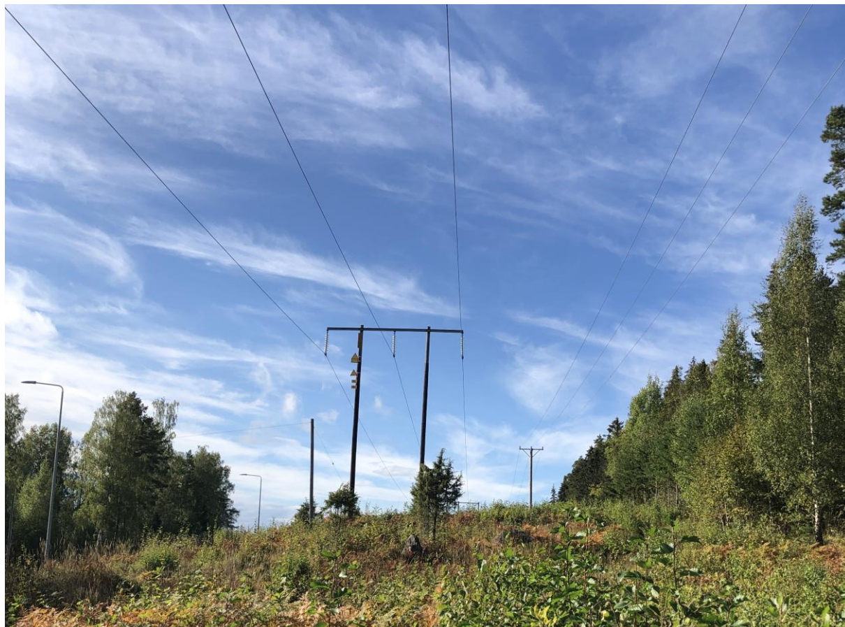
Figur 124. Befintliga ledningar L115 och en 10 kV lokalnätledning
