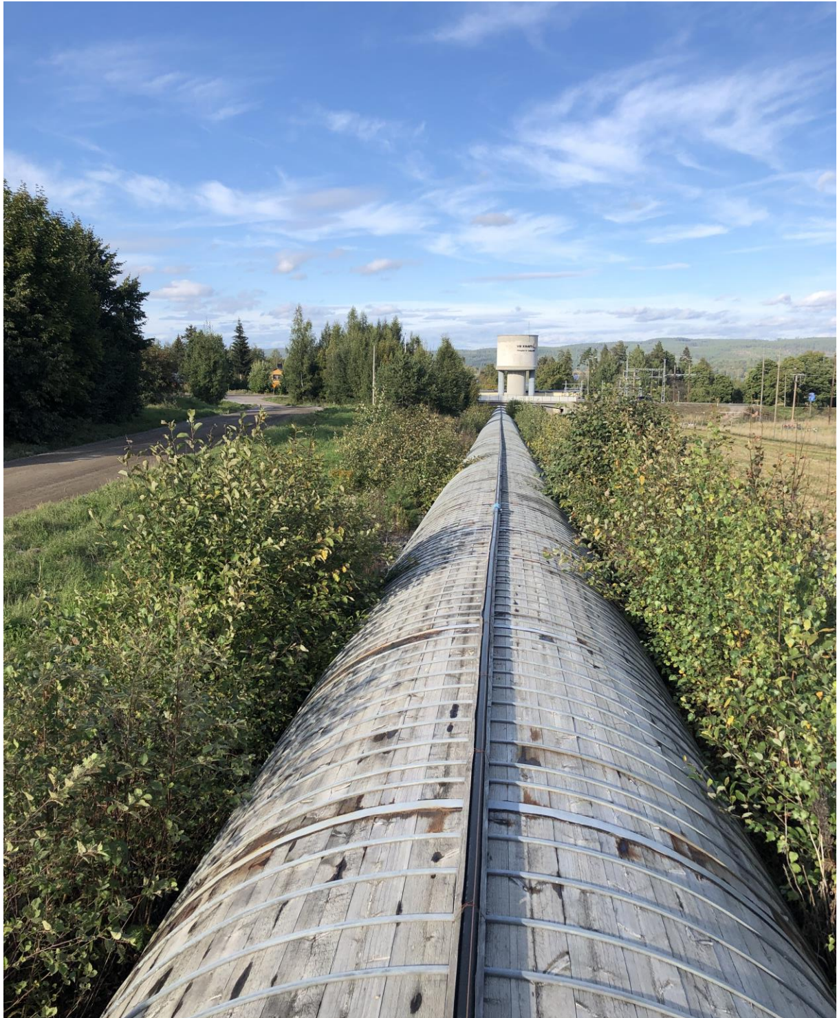
Figur 5. "Tuben" är vattenintag till Lernbo fördelningsstation
